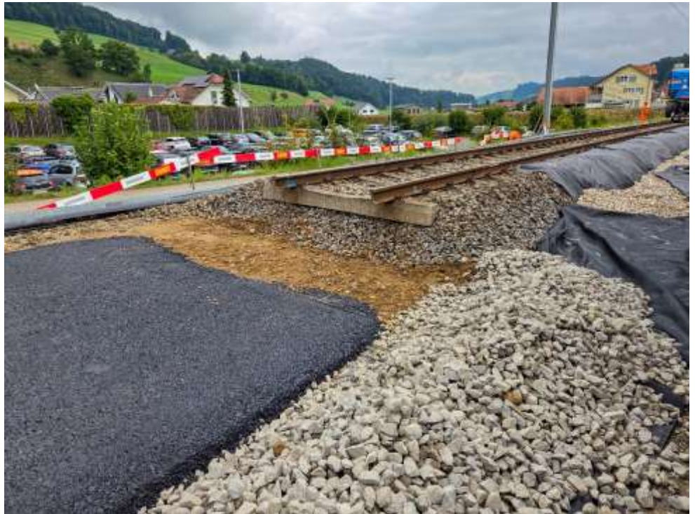
Übergang bestehendes, altes Geleise zum neuen Abschnitt mit Unterbau (Kies braun) und Fundationsabdichtung (Asphaltbelag).
