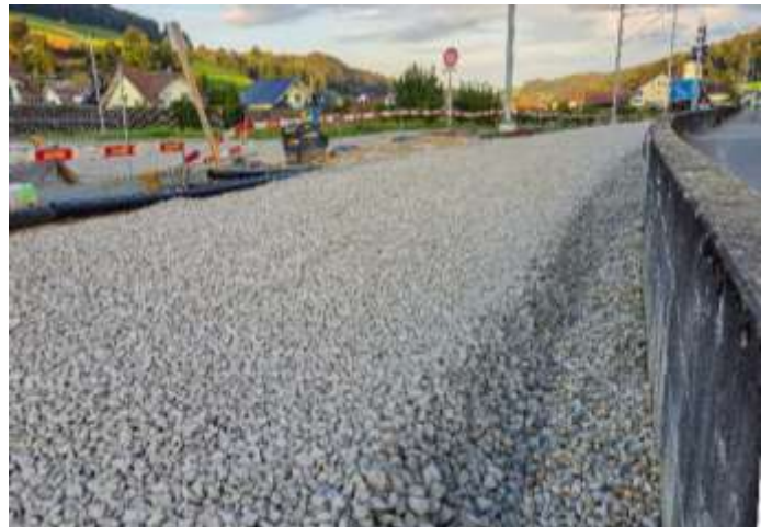
Neues Schotterbett, erstellt mit Recycling-Schotter.
